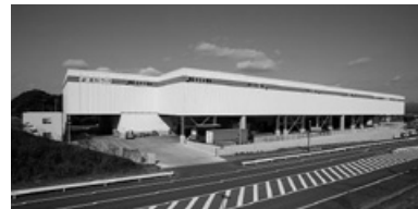
掛川平野倉庫
