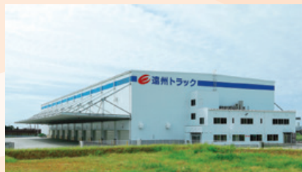
都田第2倉庫（浜松市）
