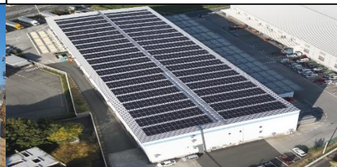
都田第2倉庫に太陽光パネル設置
